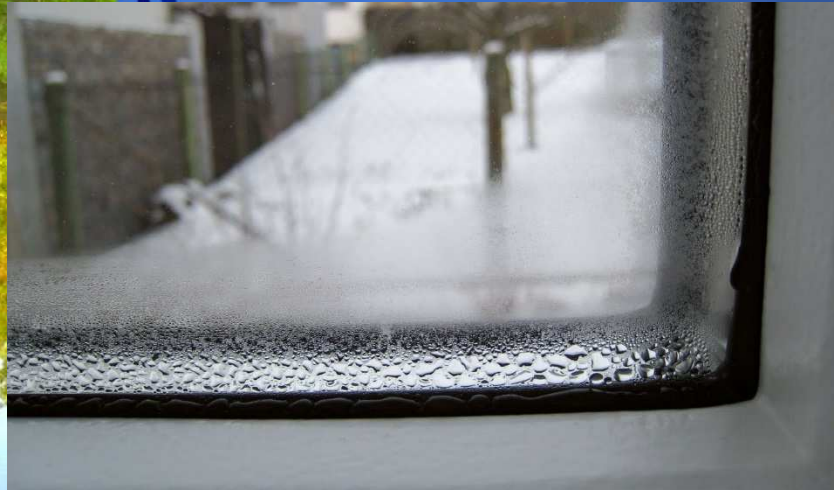
Hagyományos alumínium távtartó >>Páralecsapódás
